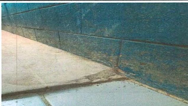
Foto 9: Piso agrietado
