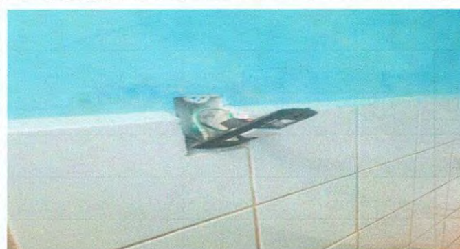
Foto 4: Tomacorrientes dañados
